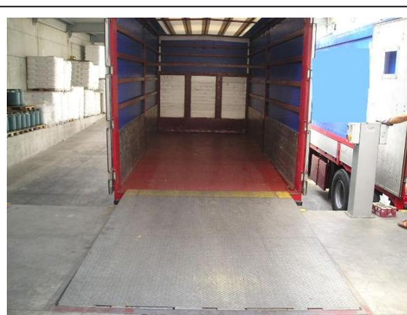
banchina di carico con rampa elettroidraulica
